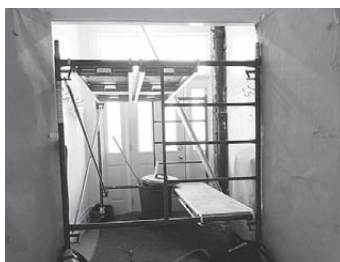
神父宿舍地下的修葺渠道漏水的工程
